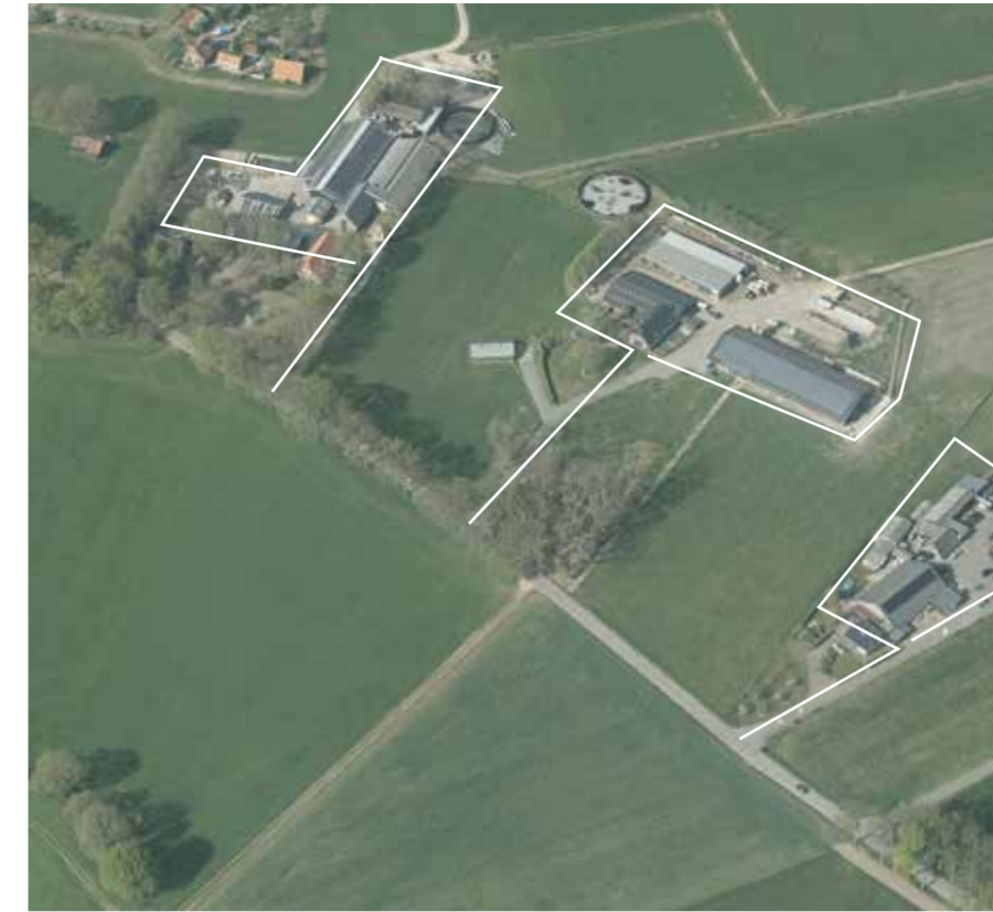
• erven langs de Cuneraweg op de overgang van deelgebied beboste toppen van de Utrechtse heuvelrug naar deelgebied Binnenveld in de Gelderse Vallei
