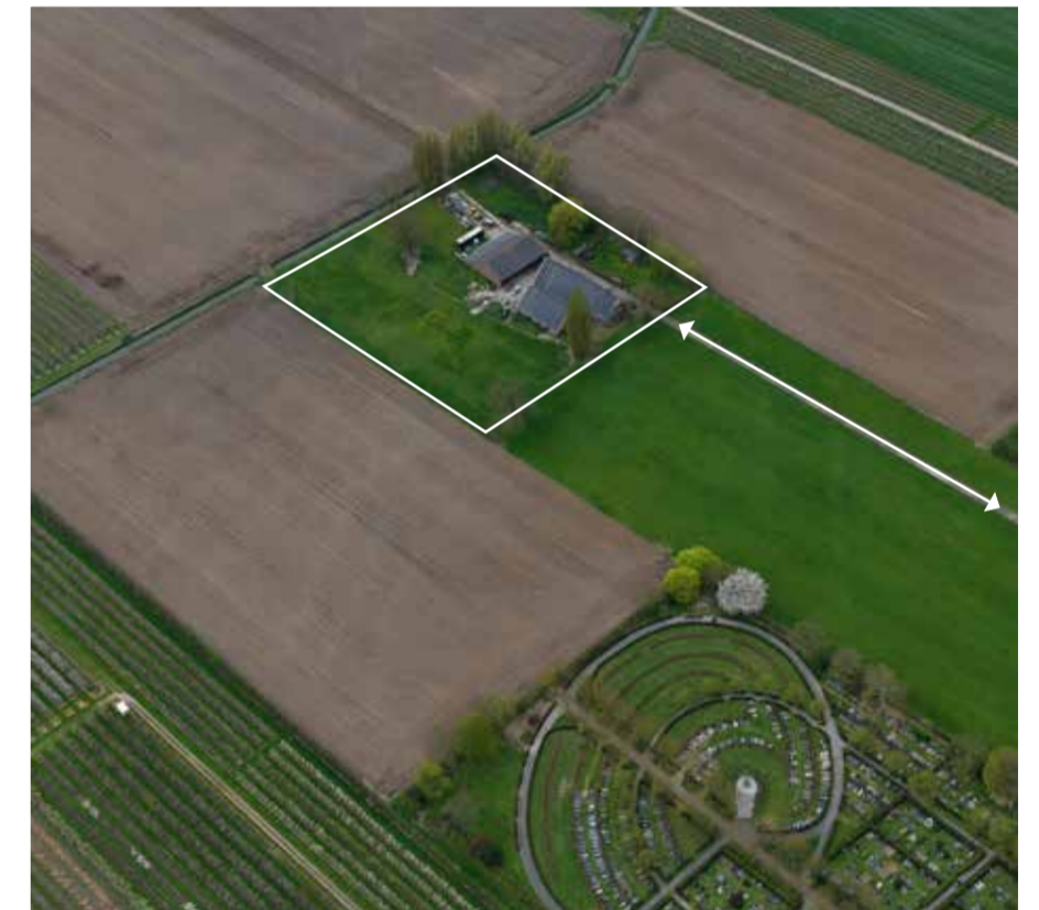
• Wilhelminahoeve langs de (voormalige) Rijnsloot, in het Rivierengebied, deelgebied Kromme Rijn
